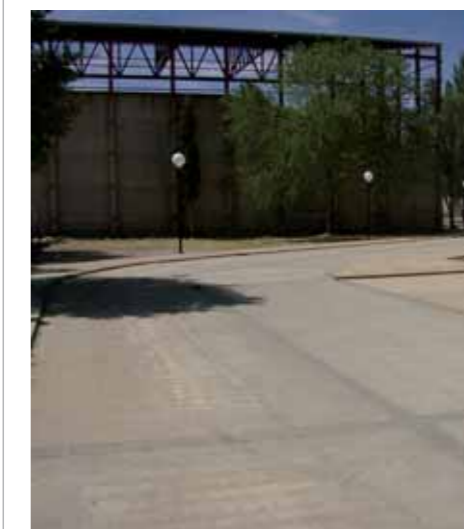
Acceso al Polideportivo
