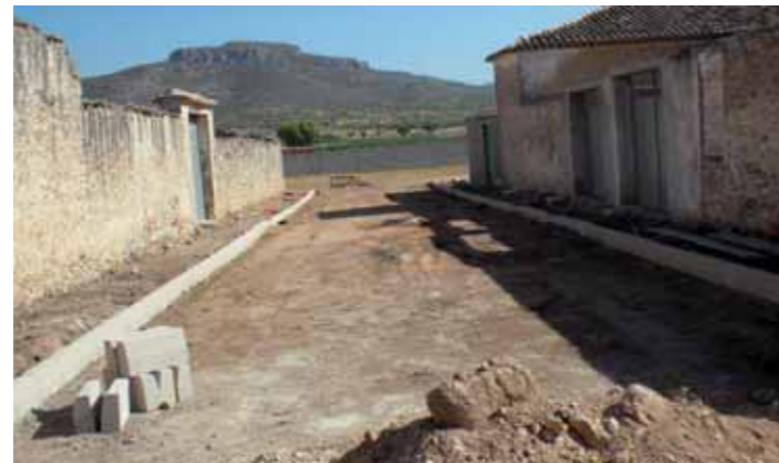
Urbanización de la Travesía de Utiel
