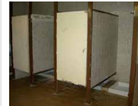
Vestuarios a remodelar
